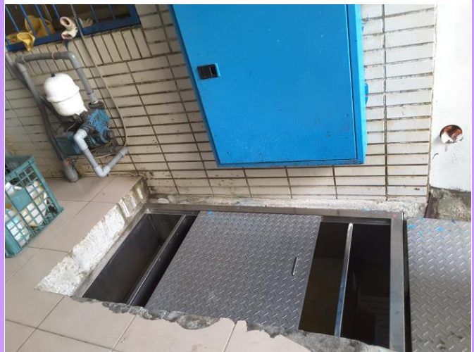
檢視截油槽清潔狀況
